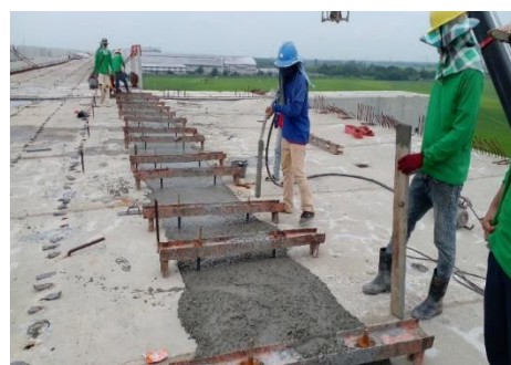
งานเทคอนกรีต Link slab สถานีลพบุรี 2
