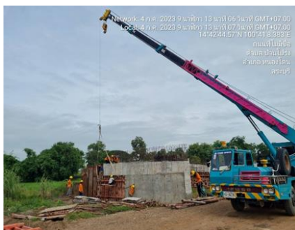
งานเทคอนกรีต Wall abutment
