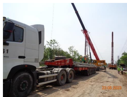
งานขนย้ายเสาแม่สำหรับก่อสร้าง
