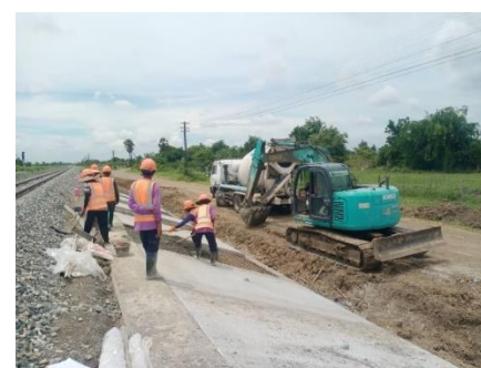
งานเทคนิค Slope Protection
