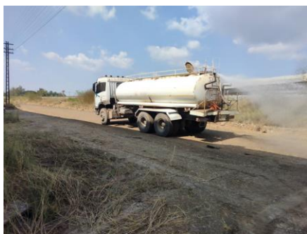
ภาพที่ 2.2-15 การฉีดพรมน้ำบริเวณที่ฝุ่นละออง
