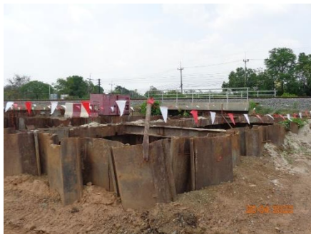
ภาพที่ 2.2-40 การกันแนวเขตบริเวณพื้นที่ที่เป็นหลุมขุด
